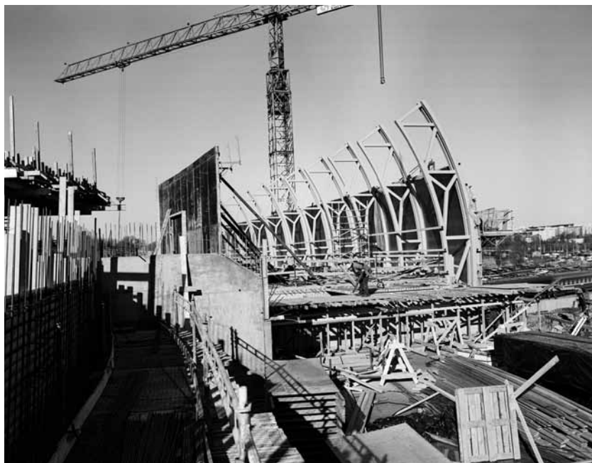
Nykytaiteen museon rakennustyömaa
